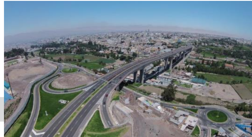
Puente Chilina, GR Arequipa
